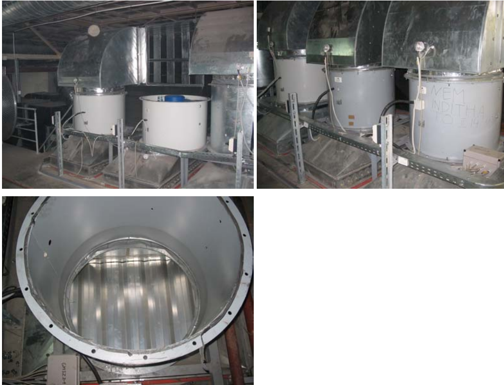
8.11. ábra. Példa axiálventilátor és motoros zsaluzat beépítésére
